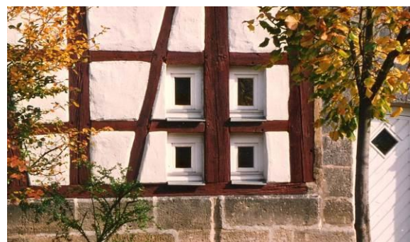
Fenster innerhalb der Gefache
