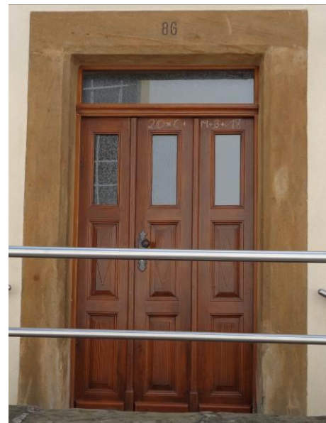
dreiteilige Türe mit Oberlicht und Lichtausschnitten
