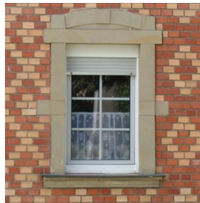
Steinfassade mit Gewände
