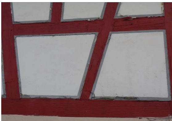
Beistrich an den Gefacherändern
