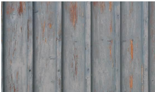
Deckleistenschalung
