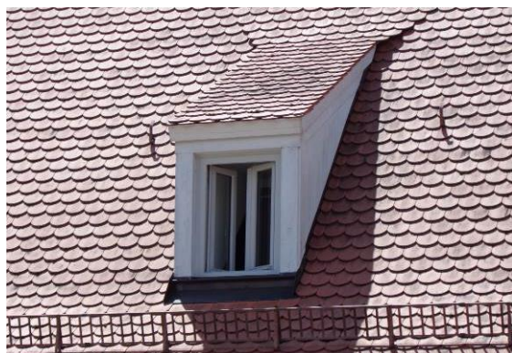
Schleppgaube, Fenster positiv
