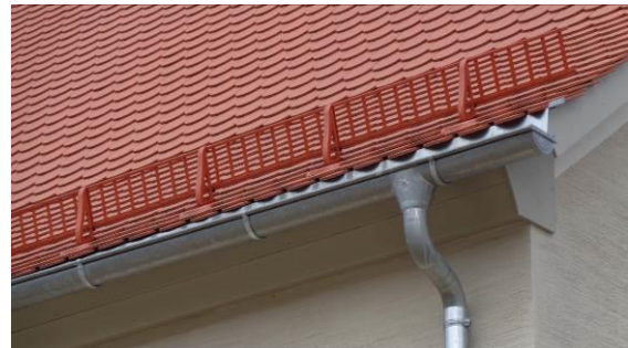
Unauffälliges Schneefanggitter
