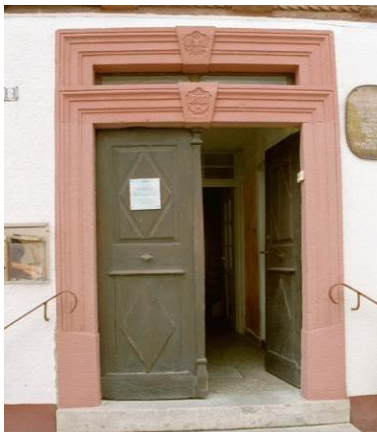
mächtiges, verziertes Türgewände mit abgetrenntem, niedrigem Oberlicht
