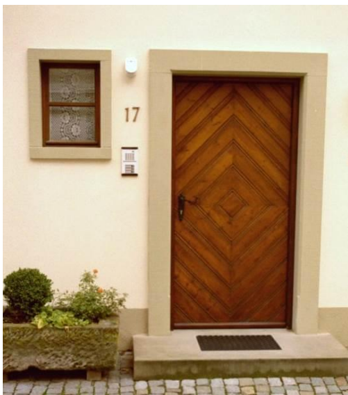
schräge Aufdoppelung – seitliches Fenster statt Oberlicht oder Glasausschnitt
