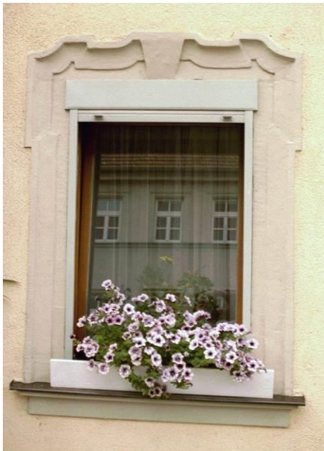
Rollladenkasten zerstört Fenstergewände
