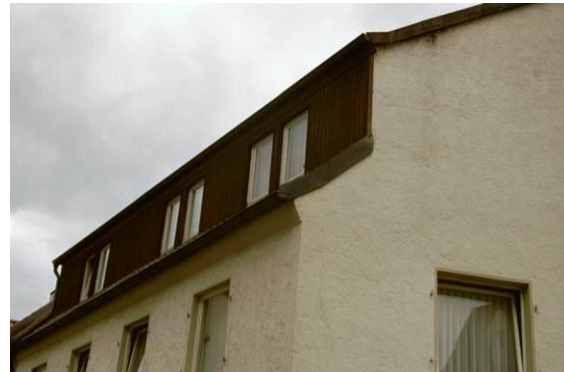
negativ: Gauben bis zum Dachrand
