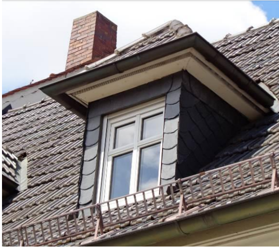
Walmdachgaube mit Schieferverkleidung
