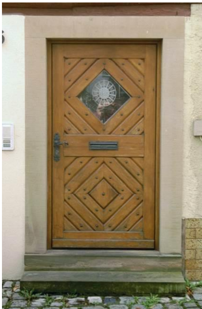
schräge Aufdoppelung mit Glasausschnitt
