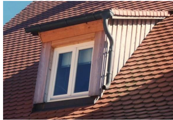
Gaubenverschalung mit Holz
