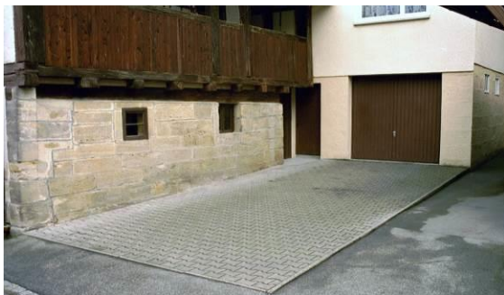
Betonverbundpflaster wirkt leblos, außerdem fehlt jegliches Grün
