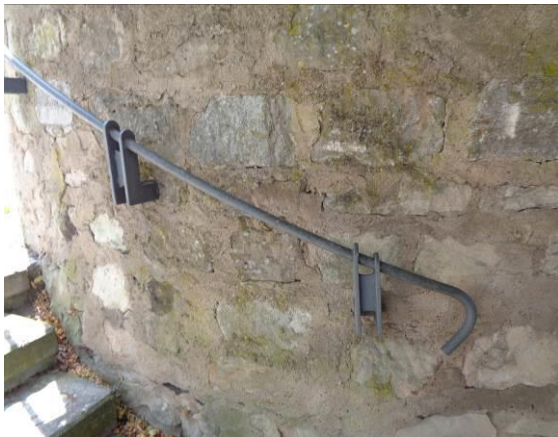
Handlauf an Natursteinmauer
