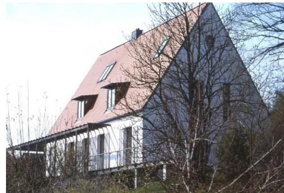
steiles Satteldach ca. 60°
