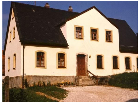
Das Zwerchhaus ist zu breit. Dadurch entsteht eine zu geringe Dachneigung.
