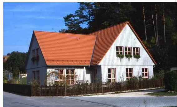
verkleidete Fachwerkkonstruktion
