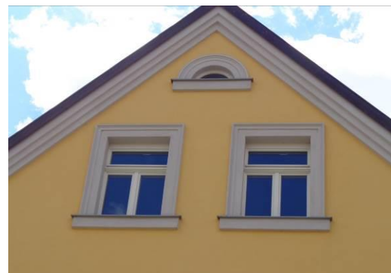
profilierte Gewände am Ortgang
