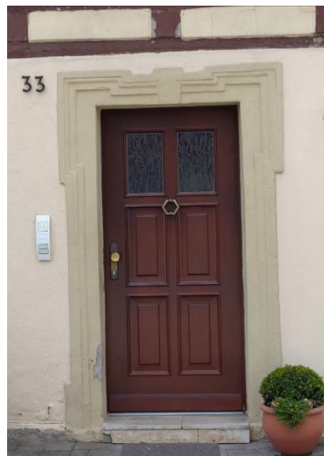
profiliertes Türgewände
