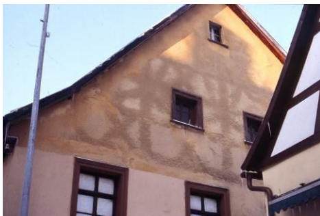
Fachwerk unter Verputz erkennbar
