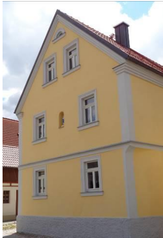
Ecklisenen, Gurtgesimse, Trauf- und Ortganggesimse
