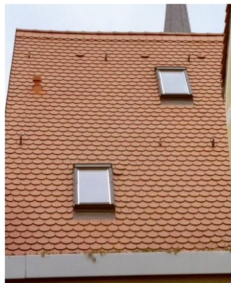
Dachflächenfenster und Biberschwanzdeckung
