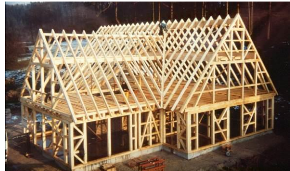
Fachwerkkonstruktion
