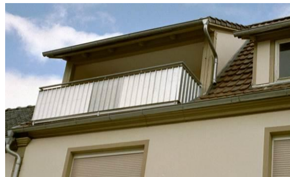
negativer Dacheinschnitt
