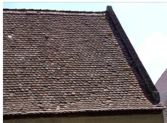
Ortgangbrandmauer
