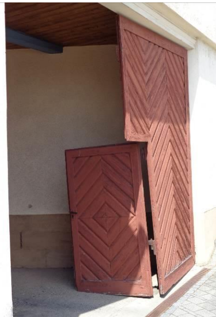
Torstruktur diagonal, mit Schlupftüre
