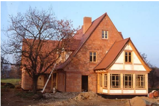
untergeordneter Wintergarten als Anbau
