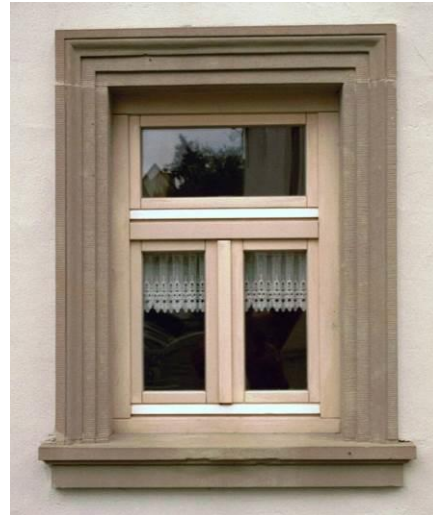
zu viel Rahmen, zu wenig Glas Breite Flügel zu Oberlicht stimmt nicht weiße Rahmenfarben wären besser
