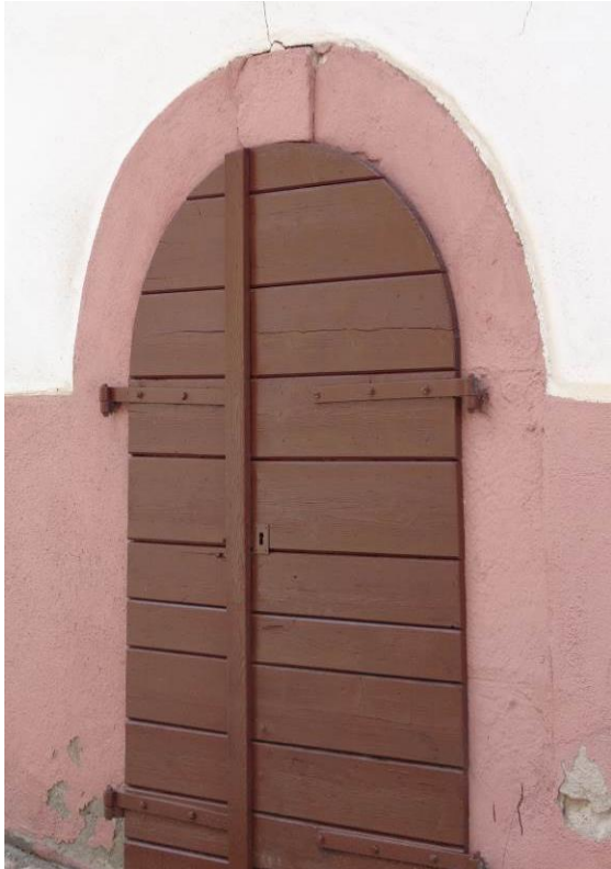
waagerechte Bretterung, ungleich breit
